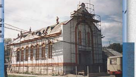
Строительство молитвенного дома.
