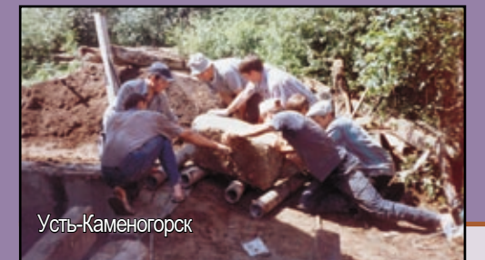
Строительство молитвенного дома. Усть-Каменогорск
